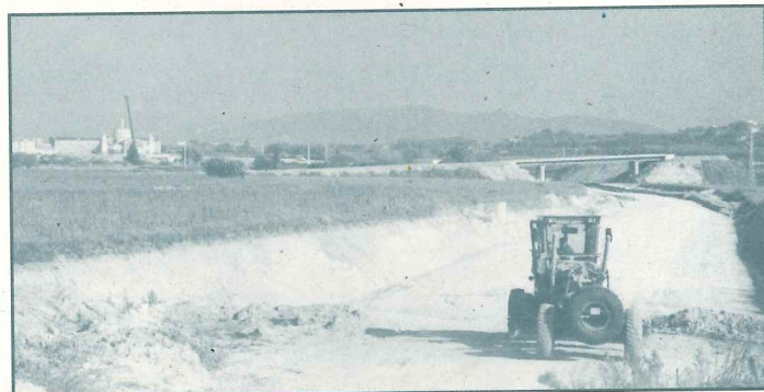
Aspecte de les obres vistes des de la carretera de Moja.
