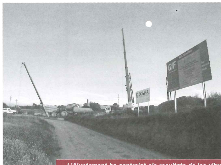
L'Ajuntament ha controlat els resultats de les vibracions amb sismògrafs instal·lats al nucli de Moja
