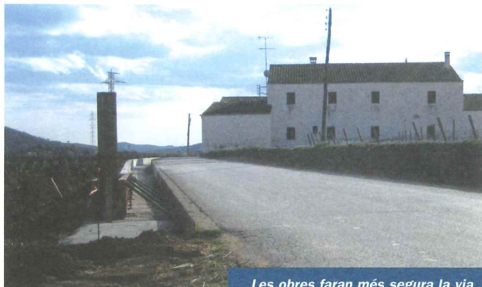
Les obres faran més segura la via
