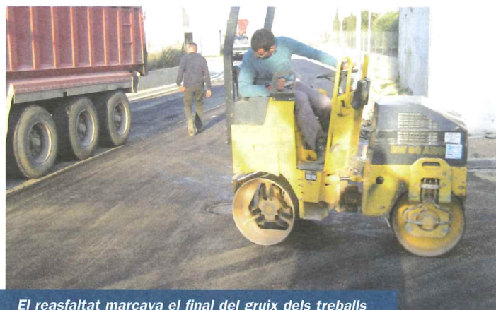
El reasfaltat marcava el final del gruix dels treballs
