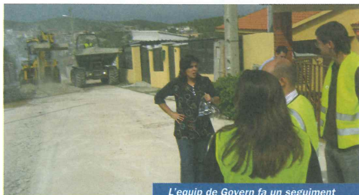
L'equip de Govern fa un seguiment puntual de l'execució dels treballs
