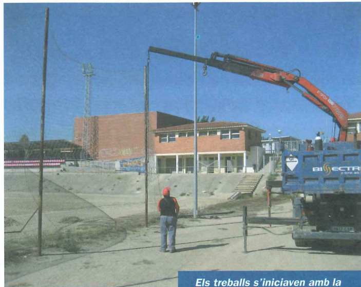
Els treballs s'iniciaven amb la retirada de tanques i porteries
